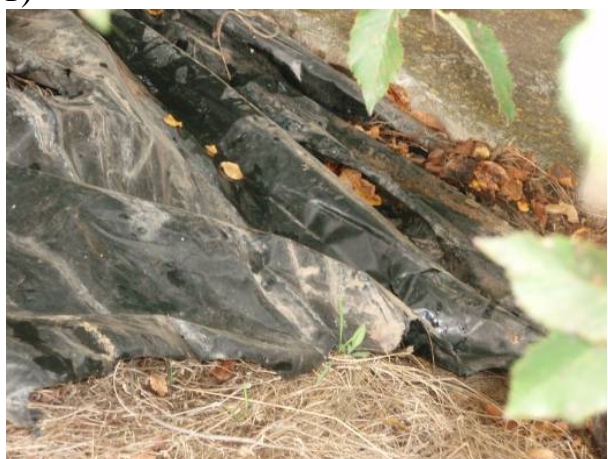
Рисунок 1– Примеры дефектов облицовки каналов и выхода фильтрационного потока в приканальную зону:
