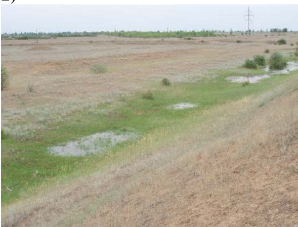
Рисунок 1– Примеры дефектов облицовки каналов и выхода фильтрационного потока в приканальную зону:
