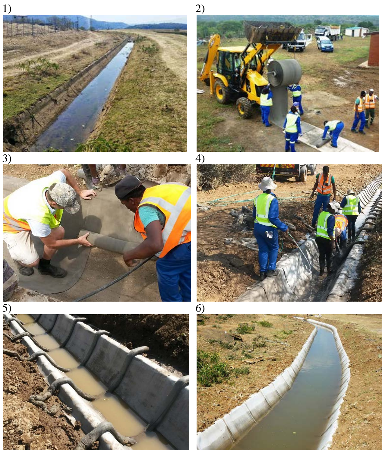
Рисунок 3– Пример производства работ с использованием бетонного полотна Concrete Canvas [7]:
