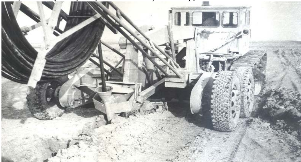
Рисунок 2 - Укладка дренажа машиной УДМ 151 в Голодной степи
