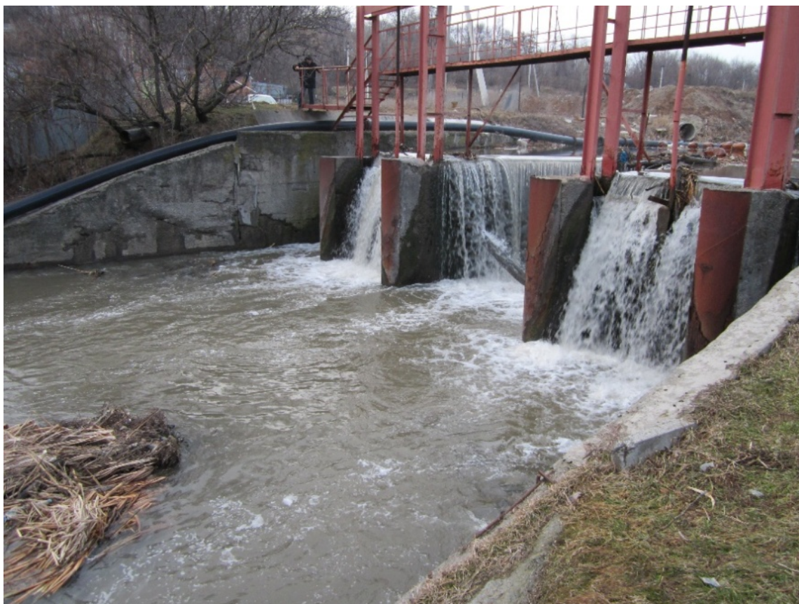
Рисунок 2 - Подпорное сооружение № 2 по ул. Зоологической
