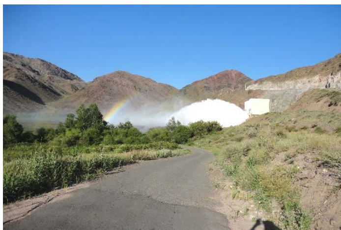
Рисунок 1 - Водовыпуск с конусным затвором Бартогайского водохранилища в рабочем состоянии
