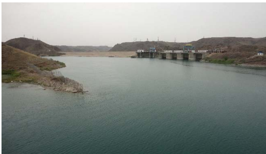
Рисунок 2 - Входной оголовок водосбросного сооружения Капшагайской ГЭС
