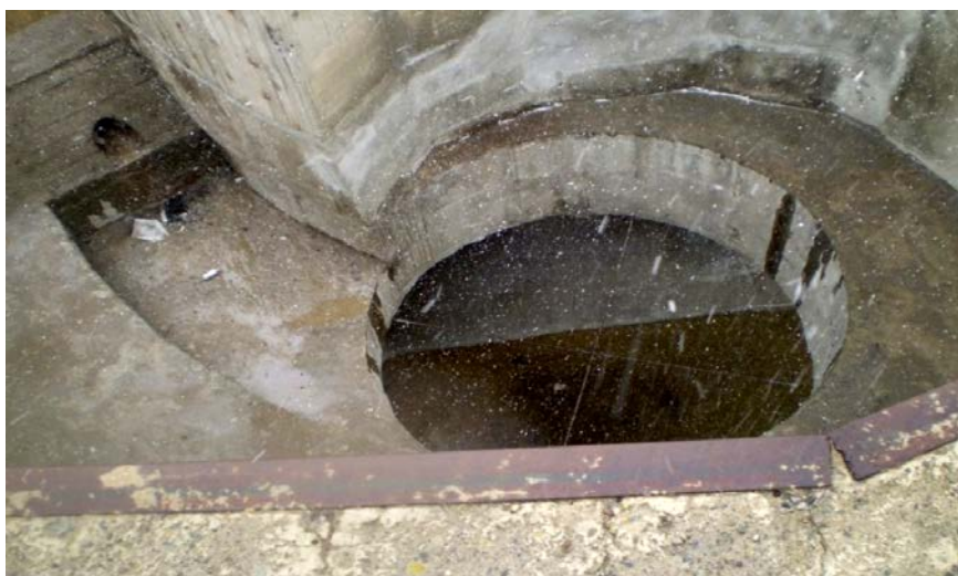
Рисунок 2 - Вихревой перепад на выходе из шахтного водосброса Бестюбинского водохранилища (Казахстан)
